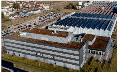
Bild 1: Auf den Dächern von Syntegon in Beringen produziert nun die leistungsstärkste Photovoltaikanlage des Schweizer EKS-Netzgebietes Strom. In den kommenden Jahren soll es zu einem Ausbau der Anlage kommen.
