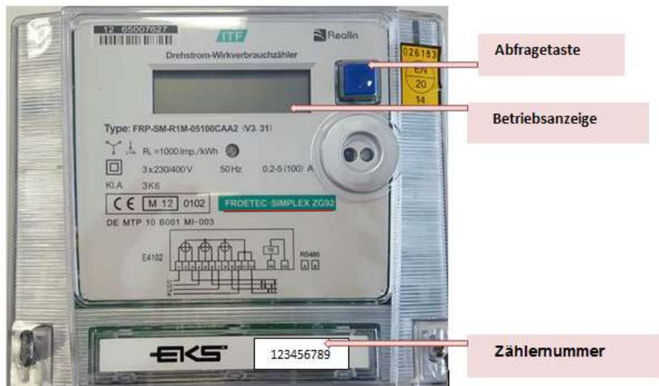
Durch kurzes Drücken der Abfragetaste (1) können die Zählwerke sowie die jeweiligen Zählerstände im Display der Betriebsanzeige (2) nacheinander angezeigt werden. Nach kurzer Zeit ohne drücken zeigt das Display wieder die Startposition.
